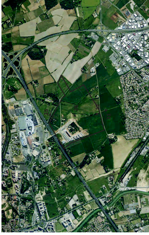
Figure 70 : Localisation des photos 21 à 26
