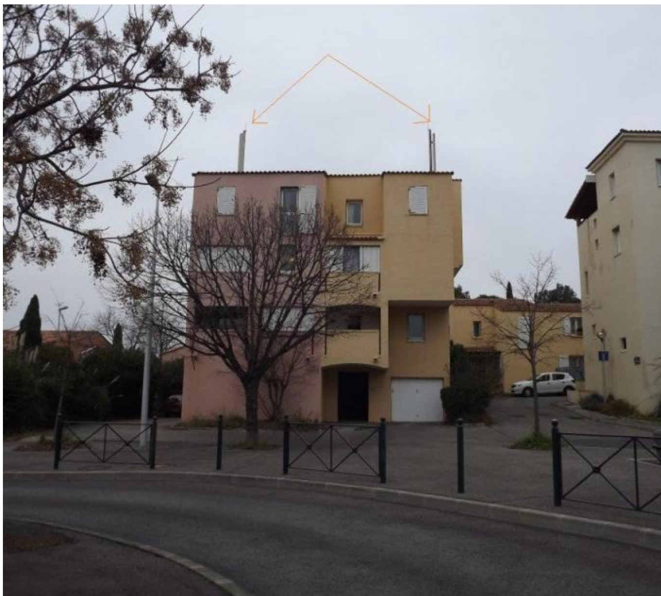
vue 1 : Photo du site existant depuis la rue du Professeur Antonin Balmes.
