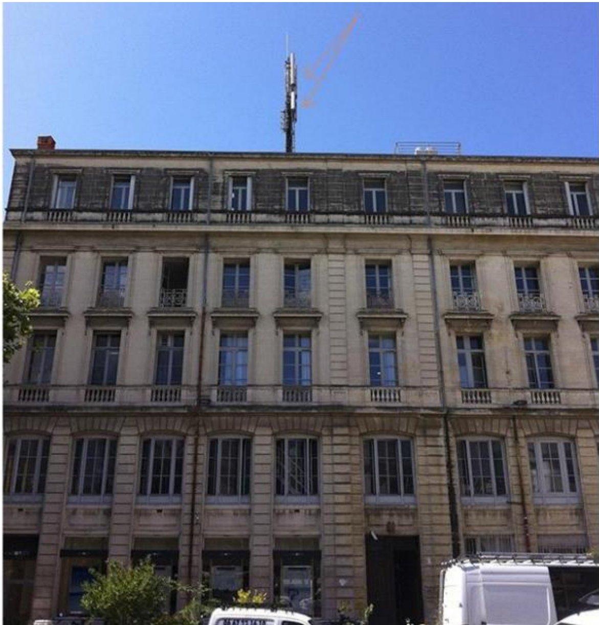
vue 2 : Vue de près. Pas de modification visuelle après travaux
