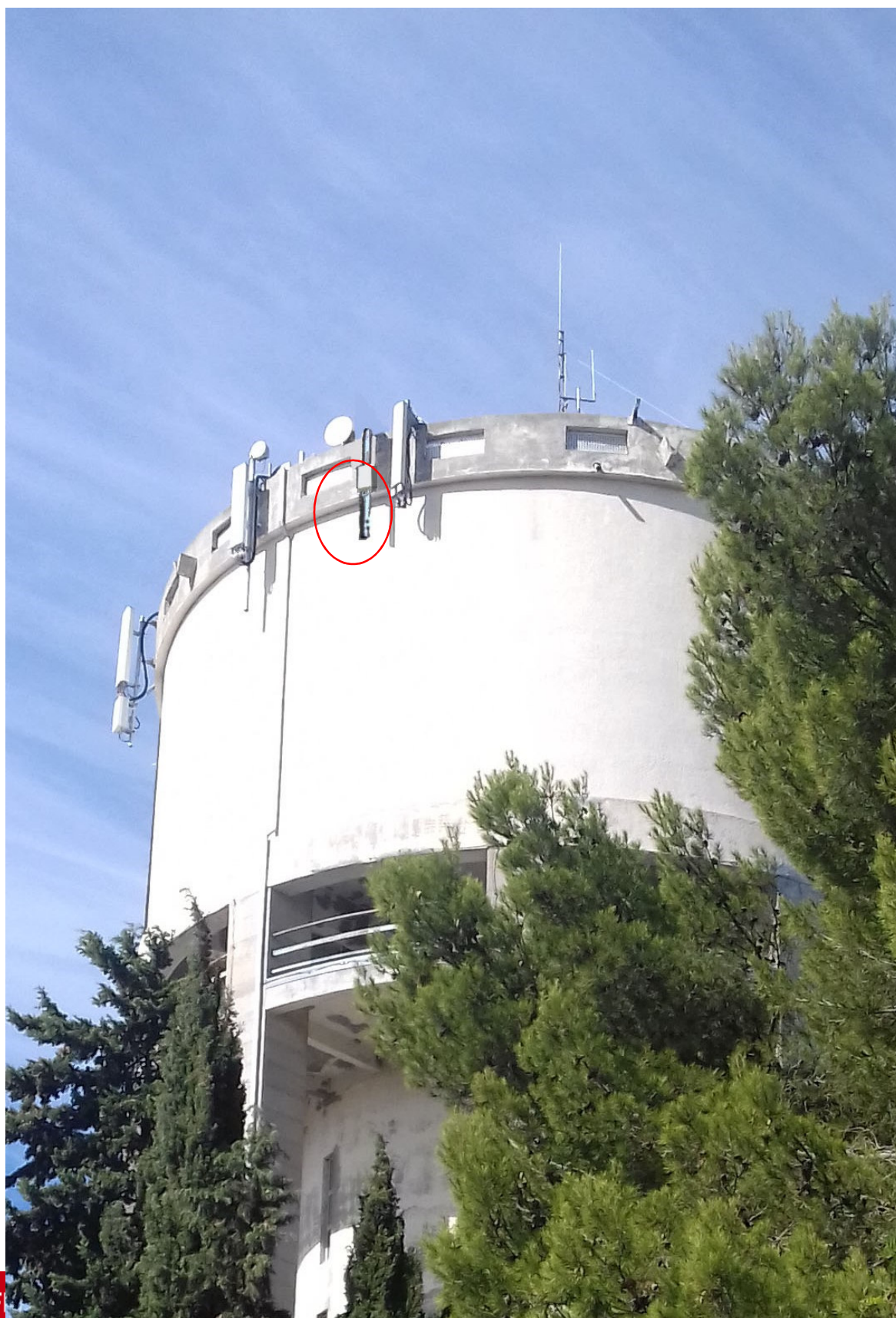
VUE 1 de près après travaux
