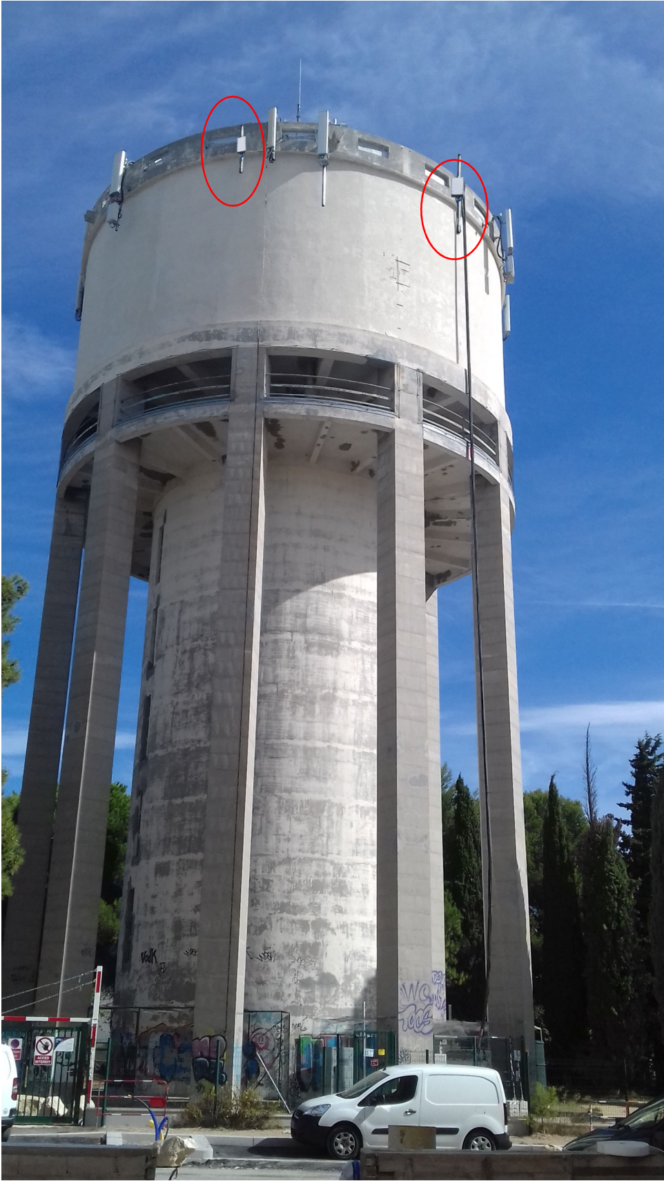
VUE 2 de loin après travaux
