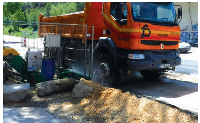
PÉDILUVE MOBILE EN ENTRÉE DE CHANTIER
