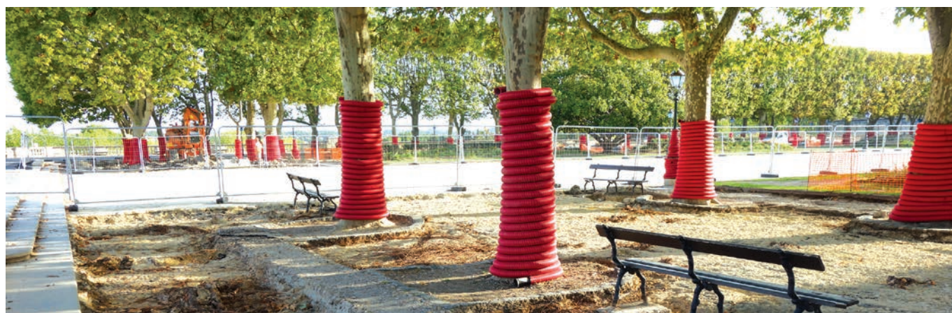
TRAVAUX DE RÉFECTION DES REVÊTEMENTS À PROXIMITÉ DES PLATANES, PROMENADE DU PEYROU (SOURCE : POUSSE CONSEIL)
