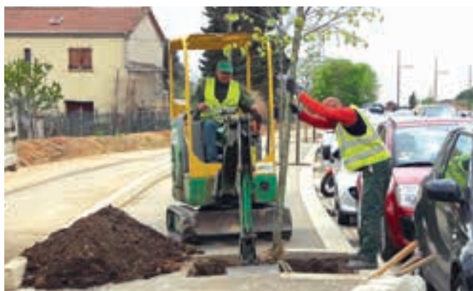
TRAVAUX DE PLANTATION, AVENUE NINA SIMONE
