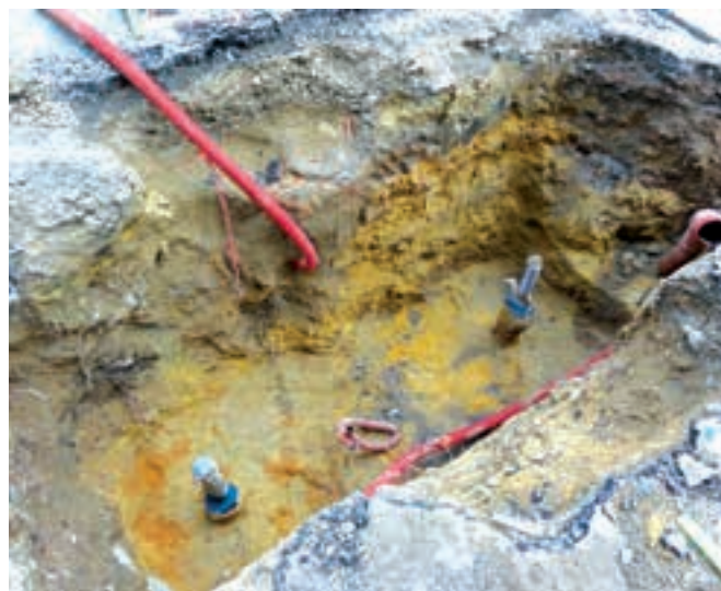
MICROPIEU EN COURS DE MISE EN ŒUVRE
