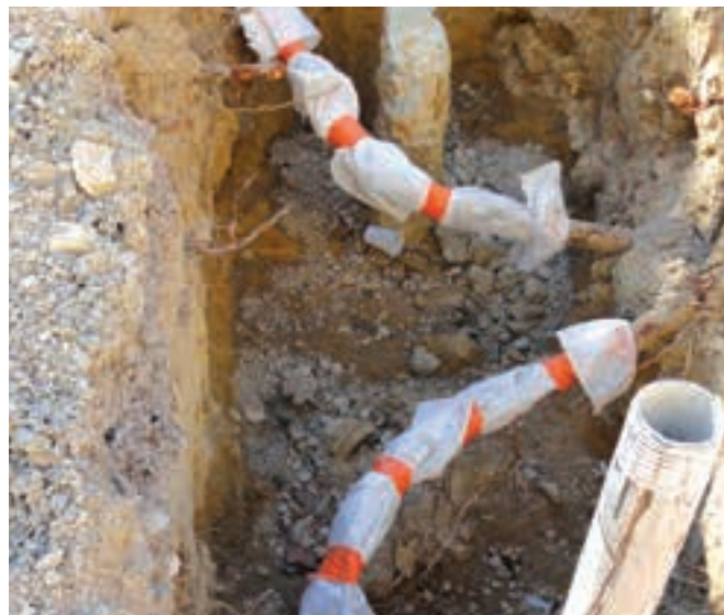
PROTECTION DE RACINES AVEC UNE GÉO-MEMBRANE CONTENANT UN SUBSTRAT TERREUX HUMIDIFIÉ DANS LE CAS DE TRANCHÉES OUVERTES PLUS DE 24H
