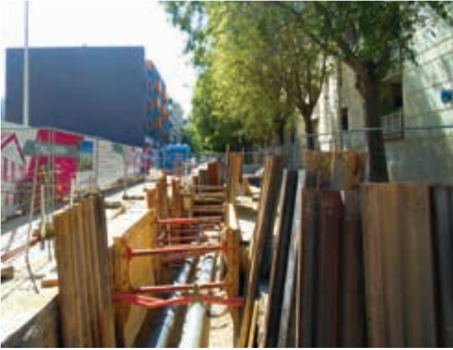
TRANCHÉES POUR RÉSEAUX, RUE DE L'ÉPIRE
