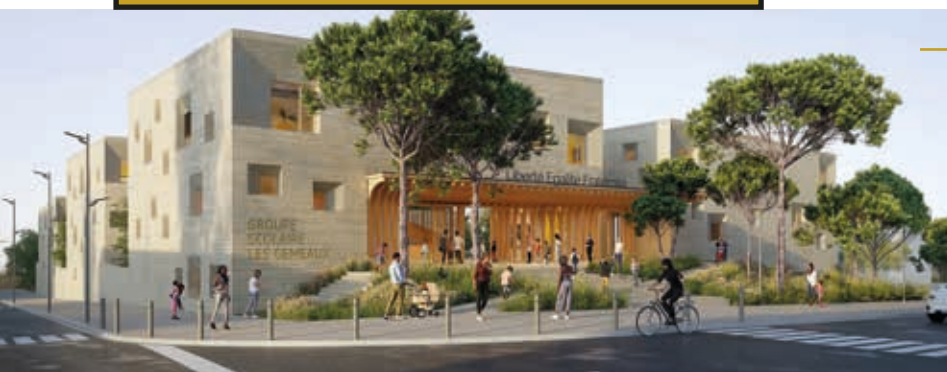
Le futur groupe scolaire Hypatie qui sera livré en septembre 2025 dans le quartier Mosson.
