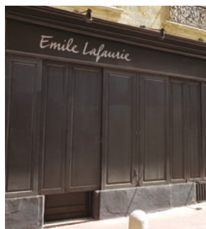
■ L'enseigne est directement peinte sur le coffrage de la devanture.
