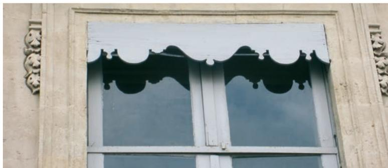
**I L'imposte ouvrante, une spécialité montpelliéraine.** L'ouverture de la partie haute de la fenêtre permet l'évacuation de l'air chaud qui monte et s'accumule dans le haut de la pièce.
