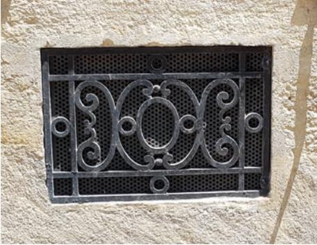
Les anciennes grilles des soupiraux placés dans les caves, doublées par un grillage en tôle perforée, peuvent servir à dissimuler un climatiseur.
