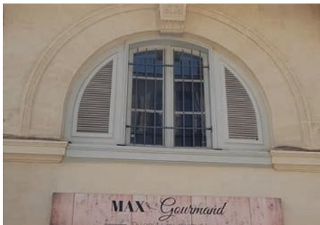
Des lattes de bois remplacent les vitrages latéraux de la baie d'entresol et dissimulent le climatiseur.
