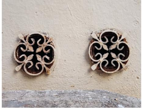
Le climatiseur est positionné à l'intérieur du bâtiment. Les prises d'air sont dissimulées derrière des grilles en fonte ouvragée.
