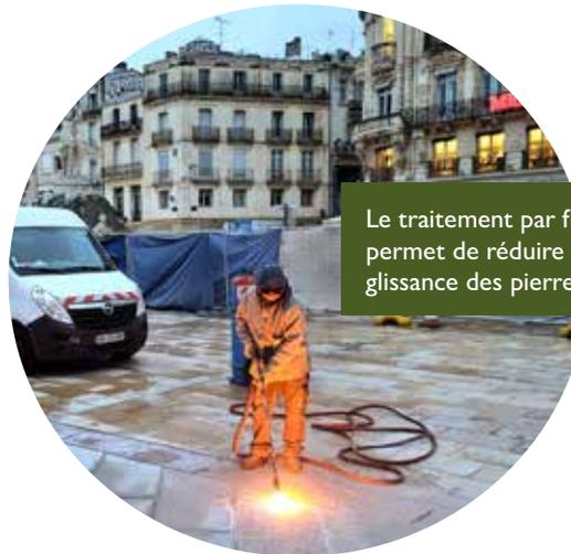
Le traitement par flammage permet de réduire la glissance des pierres
