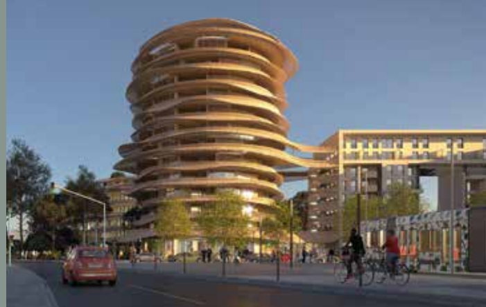
FOLIE OASIS quartier Ovalie : Architectes Coldefy et Van Haute, OGEPROM, 53 logements dont 16 en Bail Réel Solidaire (BRS) (OFS Métropolitain) du T2 au T4
