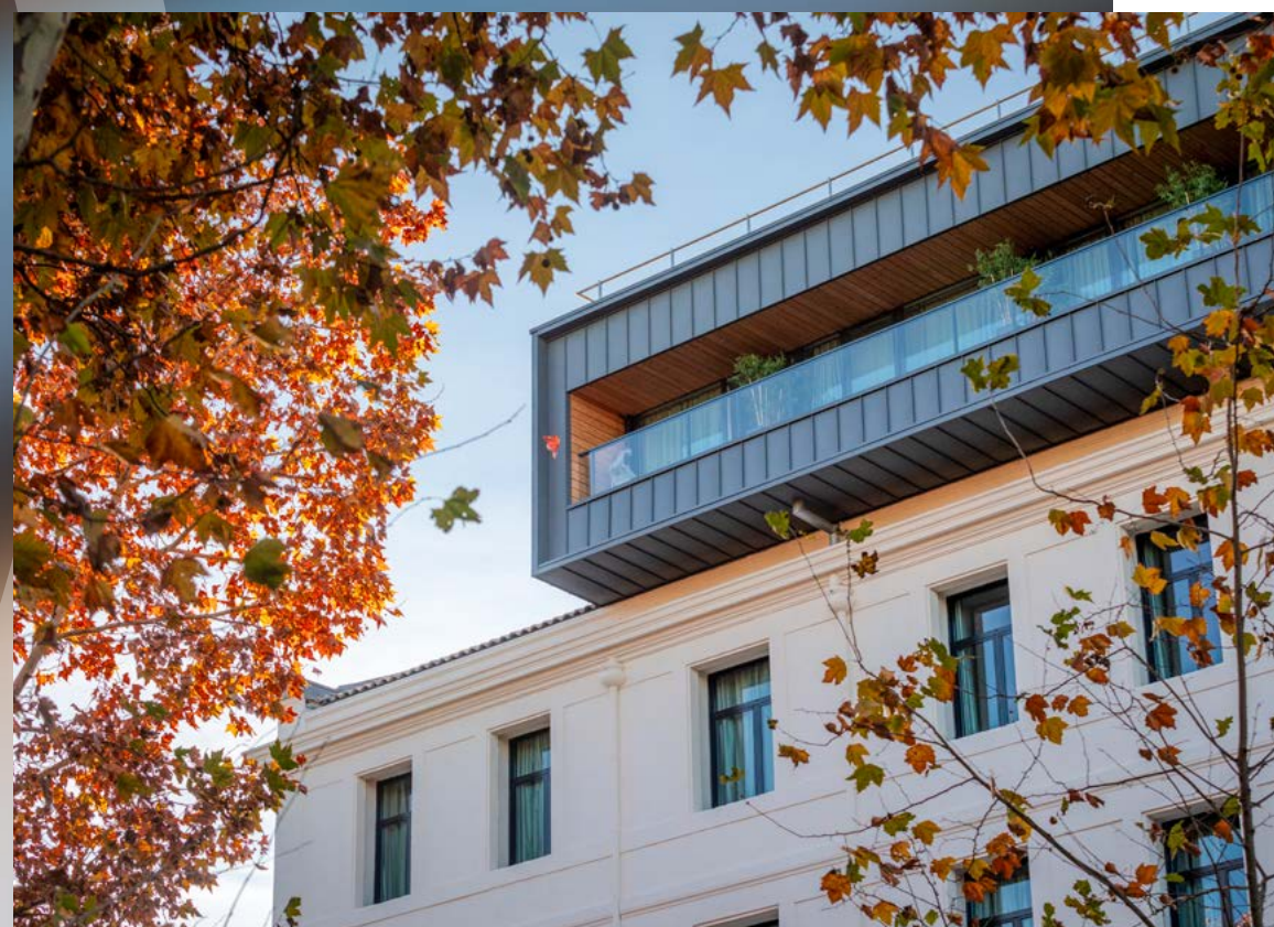
Réhabilitation d'un bâtiment de l'ancienne École d'Application de l'Infanterie, ZAC Cité Créative (West 8 architecte). ©Sedat Yagiz
