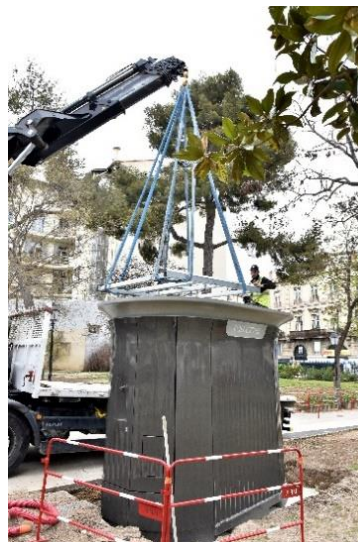
Installation de toilettes publiques
