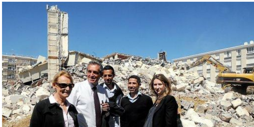
Démolition de la Tour H du quartier Petit Bard
