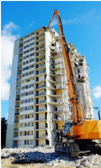
Démolition de la Tour d'Alembert (Hauts-de-Massane)
