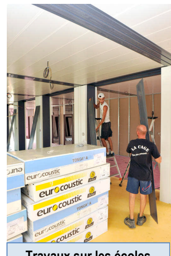
Travaux sur les écoles
