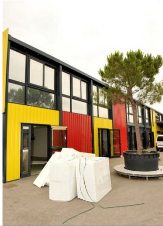
Travaux sur les écoles
