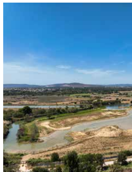
Restauration hydromorphologique de la basse vallée de la Mosson
