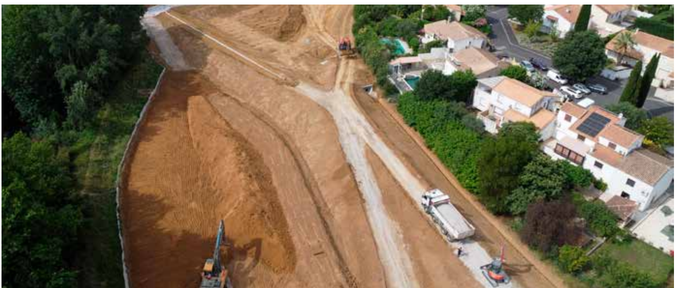
Chantier de protection contre les inondations de la Mosson à Juvignac
