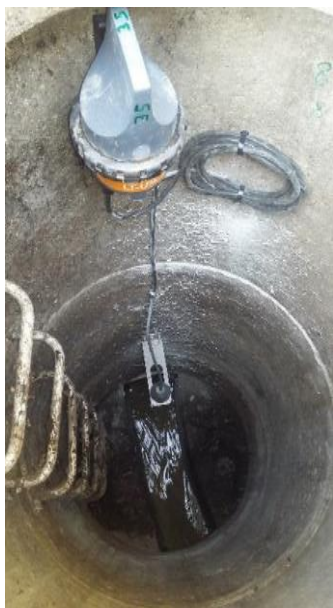
Sonde de mesure de hauteur d'eau
