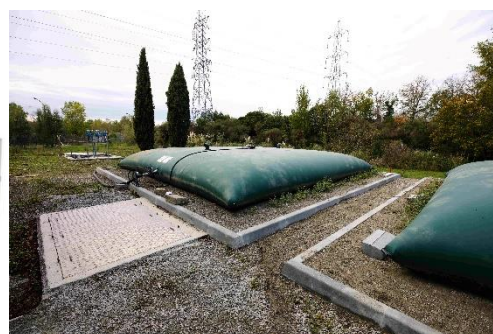
Bâches de stockage
