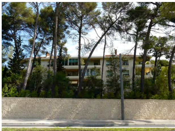
L'installation de capteurs solaires en toiture peut perturber la lecture des bâtiments dans l'ambiance urbaine.
