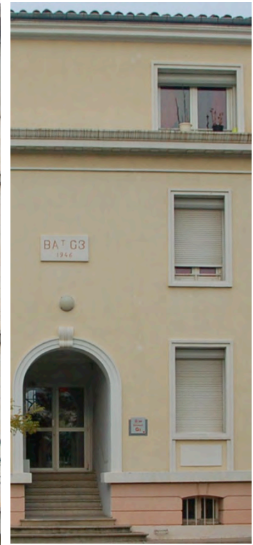
Cité De Lattre de Tassigny Bloc Volet/fenêtres en PVC
