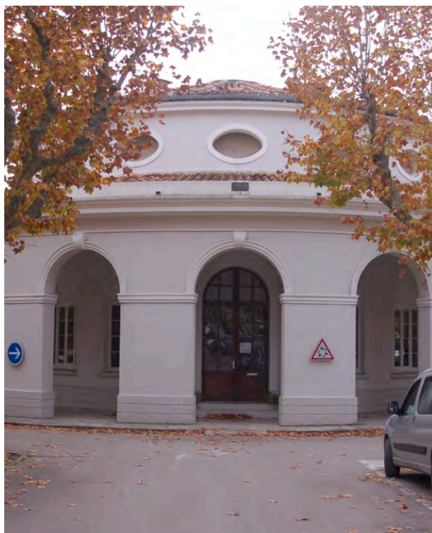
Façade en ciment
