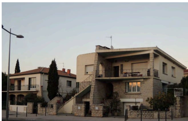
Pavillons 1950/1970 toit terrasse
