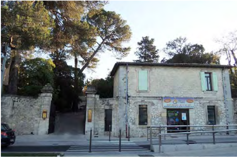
Pavillon d'entrée de la Villa «Antoinette Bermond» 109 av de Lodève - 1912
