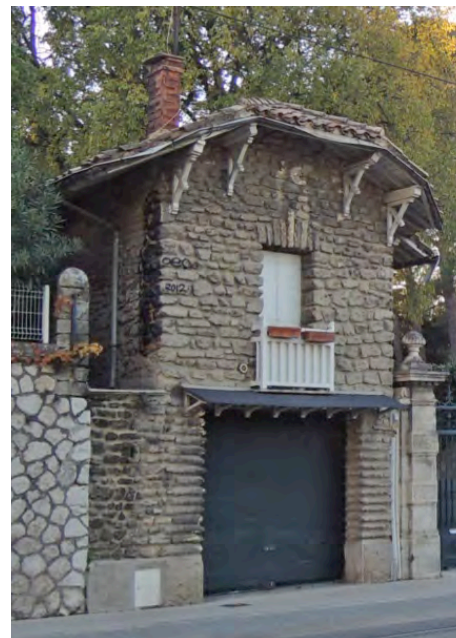
Mur en moellons façon meulière
