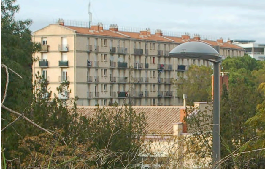
Les dénivelés depuis l'avenue de Lodève laissent voir les toits en vue surplombante.
