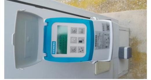
Remplacement du débitmètre électromagnétique mesurant les volumes refoulés vers l'ouvrage de siphonnage alimentant les lits plantés de roseaux.
