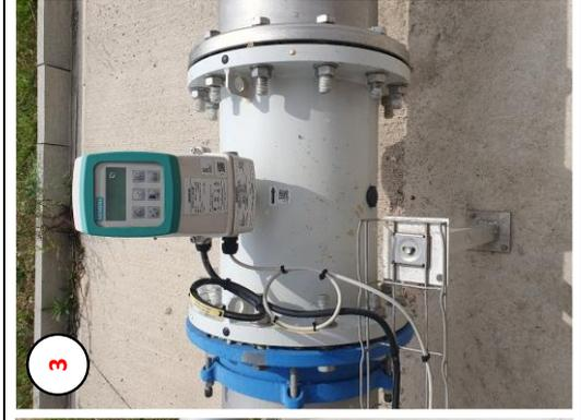
**1** : débitmètre électromagnétique mesurant les effluents en Entrée de station
