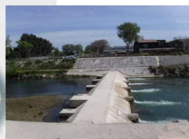
Station 2 : Pont Trinquat (aval Montpellier)
