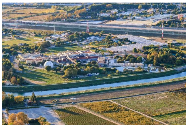
STEU MAERA – commune de Lattes – Vue du Ciel
