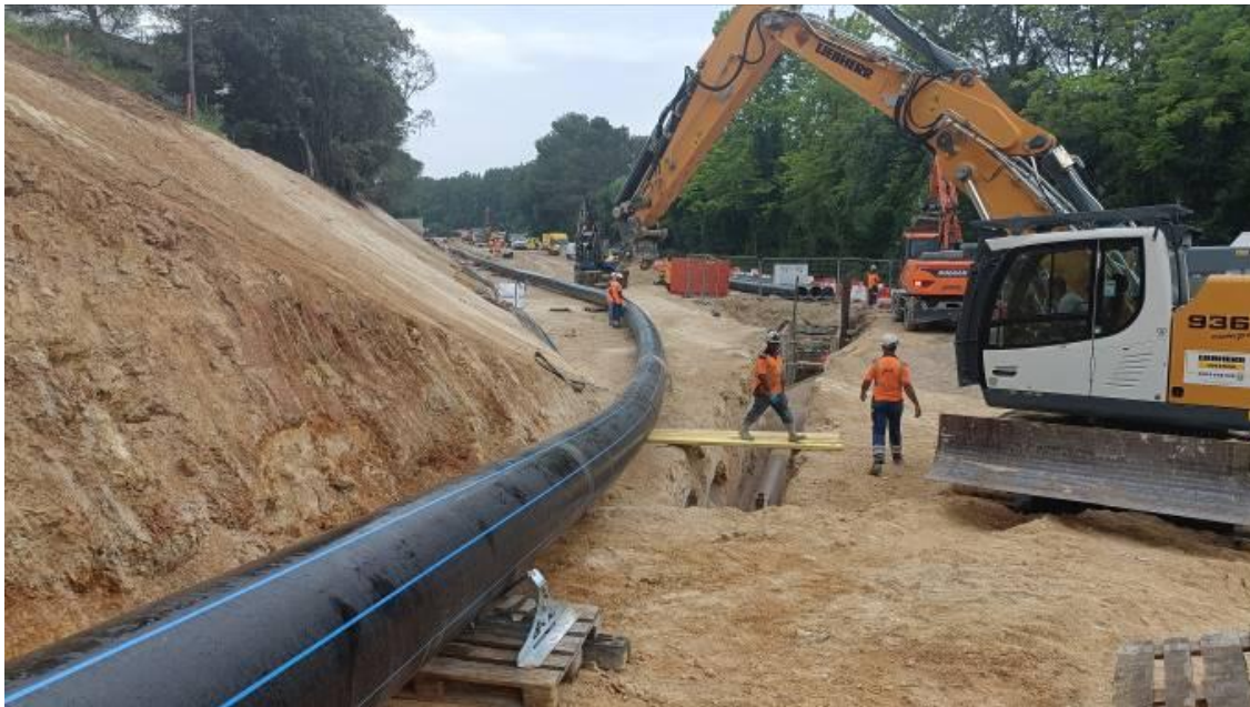
Figure _ travaux sur le DN1000 _ tubage
